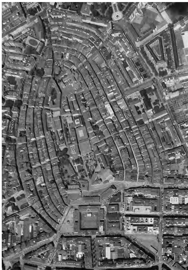
Figura 5: La vista en picado descubre los matices de la planificación sucesiva: el núcleo ovalado en Villa Suso y el trazado concéntrico envolvente de las dos barriadas laterales. FOAT.
