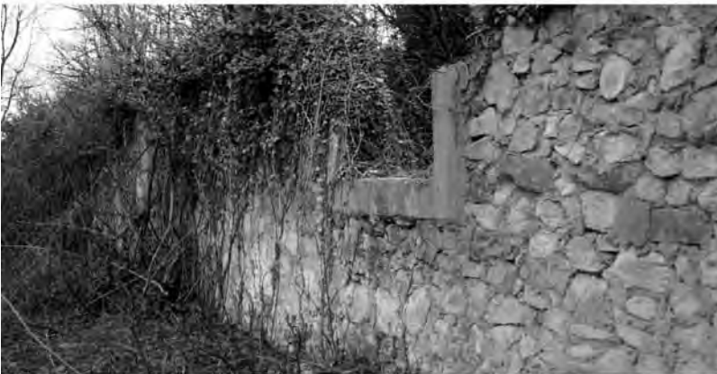
Ruinas de los barracones de Lezo alto (2004)
