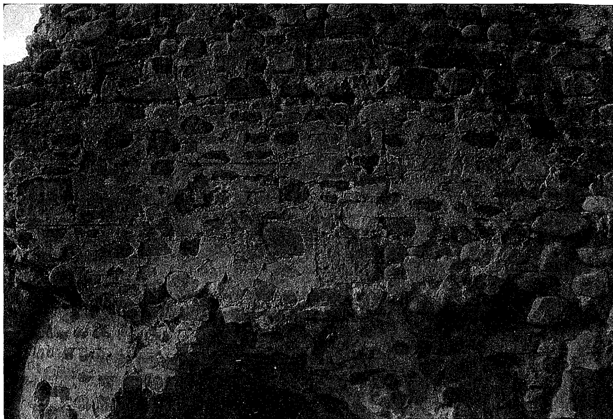
Fig. 8. Arnedo (La Rioja) Detalle del muro norte del castillo dnde se ve la utilización simultánea de la técnica del sillarejo y el encofrado.
