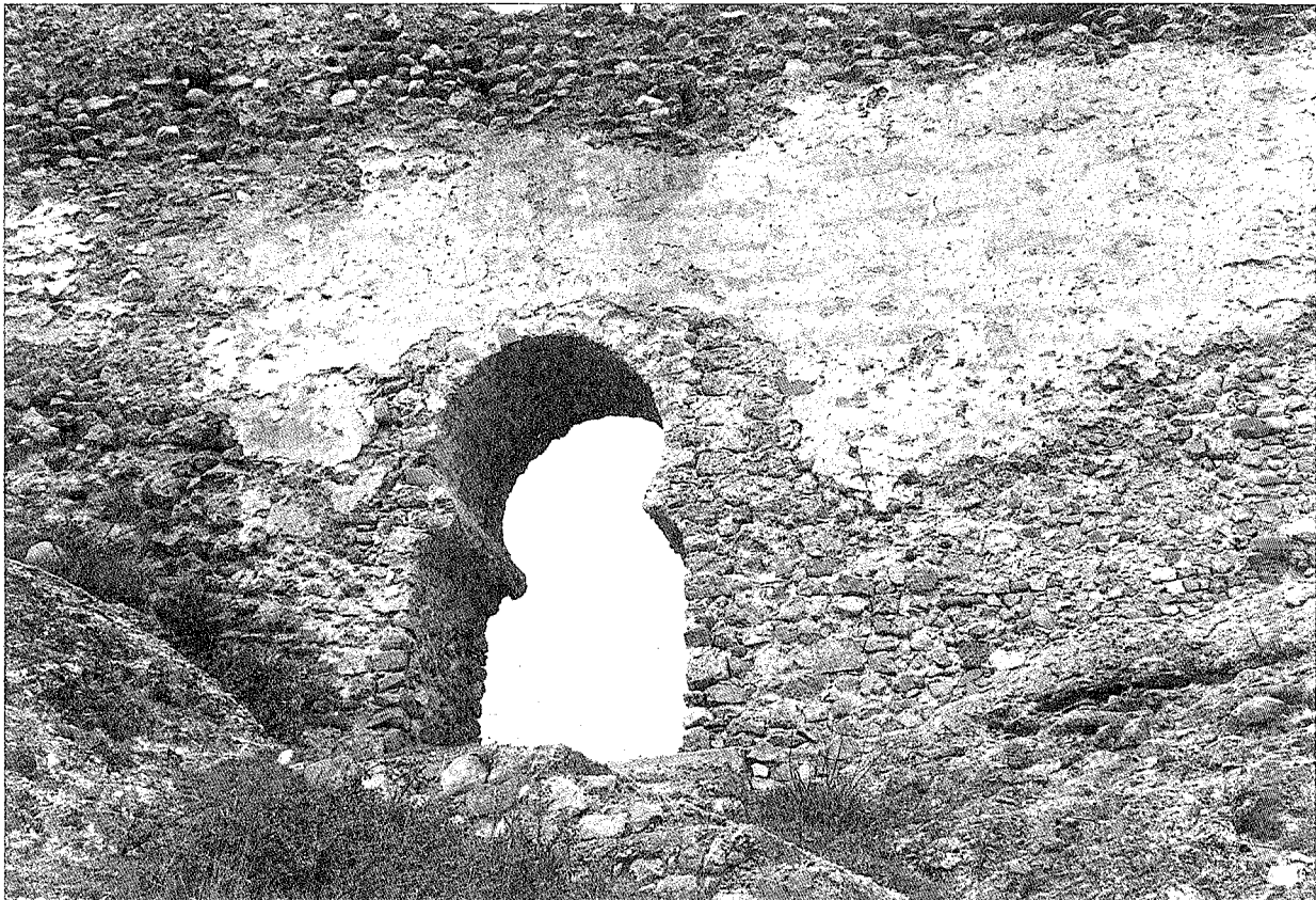
Lám. 6. Castillo de Clavijo. Vano desde el interior de la torre del homenaje.
