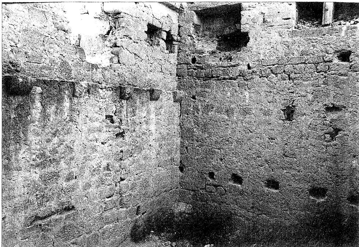
Lam. 7. Castillo de Quel. Torre. Detalle de la parte inferior del ángulo sur-este.
