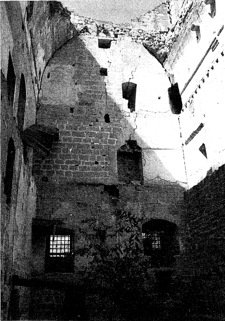
Lám. 19. Interior de la torre fuerte hacia oeste.
