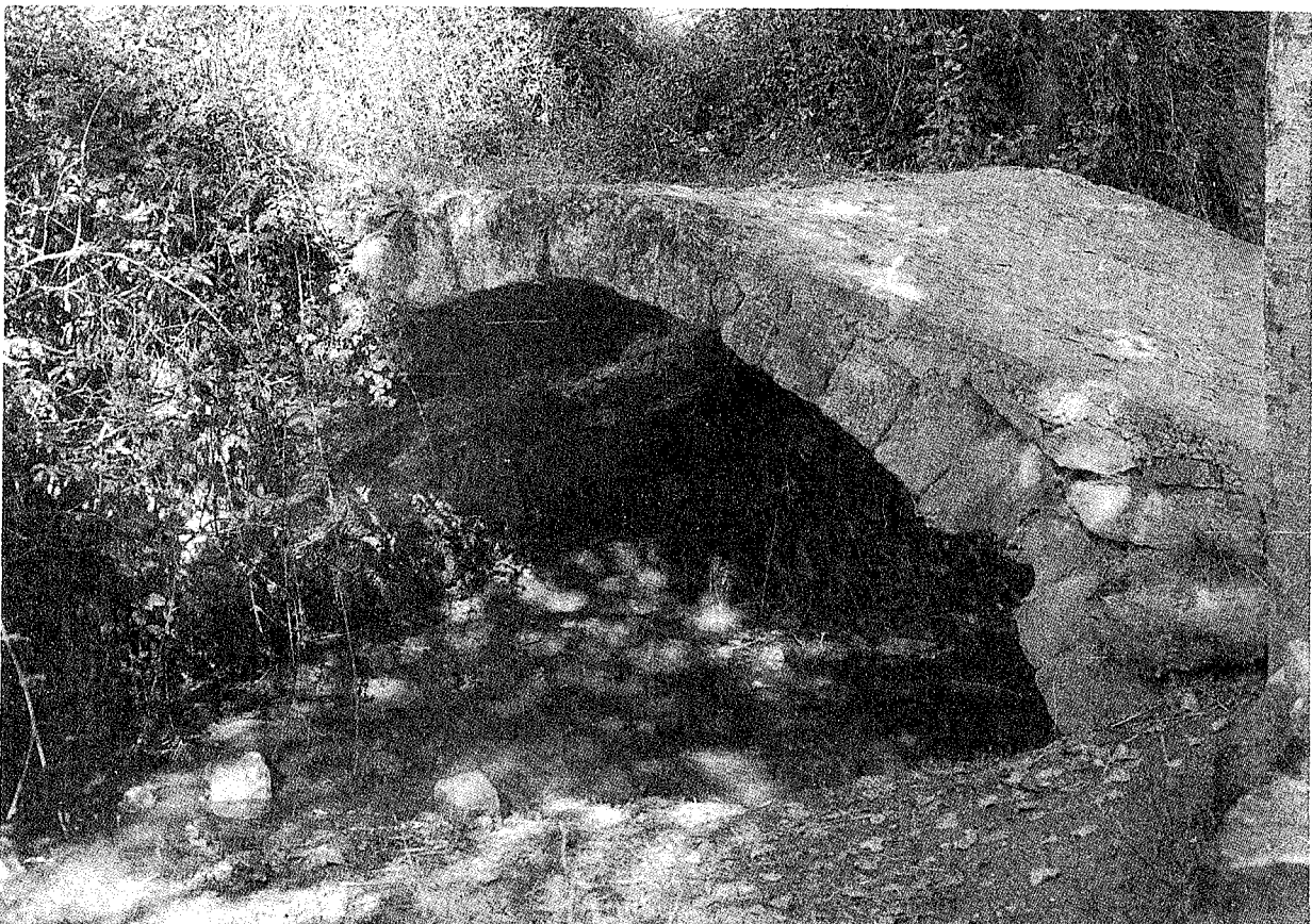
Lám. 4. Puente en el camino a Pancorbo sobre el Mardancho.
