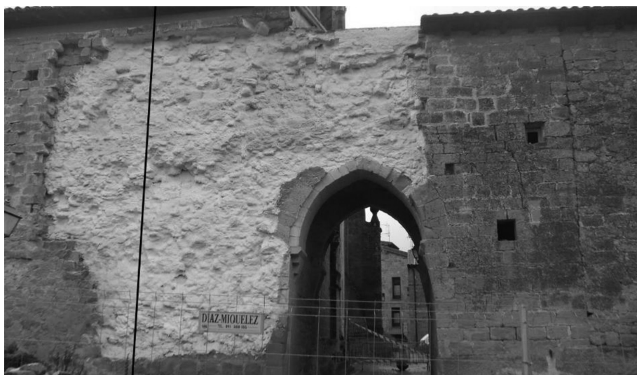
Figura 13. Puerta del Arco (la línea negra marca las dimensiones originales).
