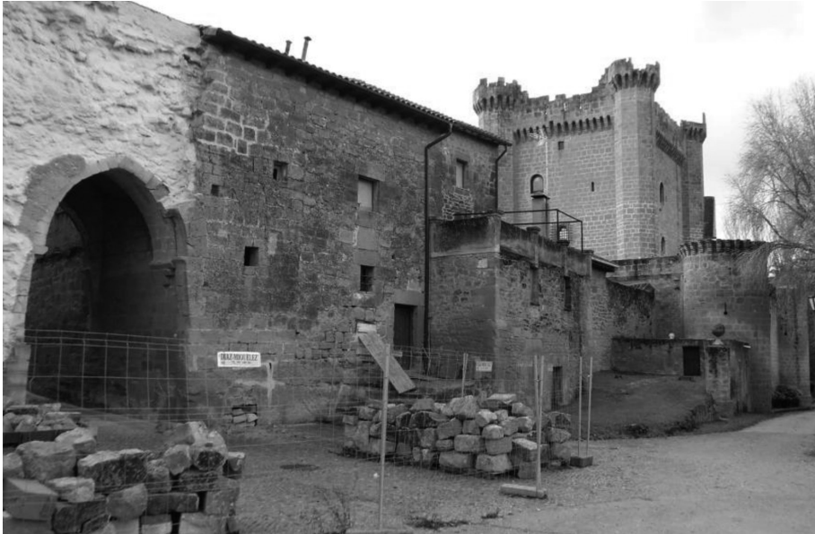
Figura 3. Fachada septentrional del antiguo ayuntamiento y castillo.
