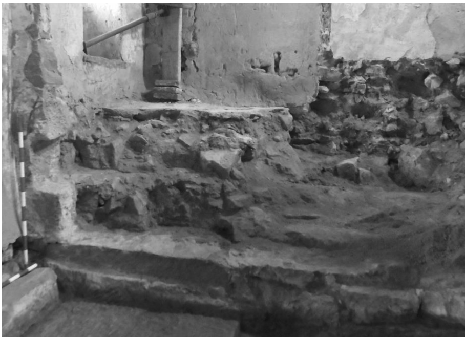
Figura 8. Relleno del estribo y, debajo, banco de cimentación tallado en la roca.
