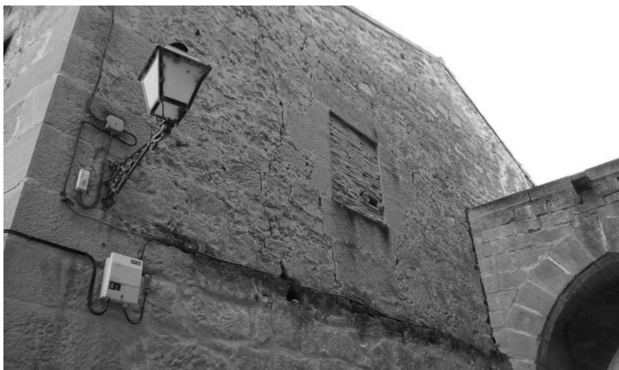
Figura 20. Fachada este del antiguo ayuntamiento.
