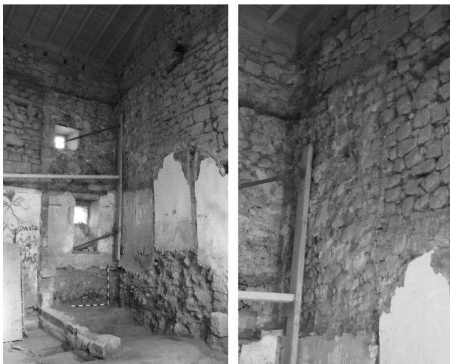
Figura 12. Vistas del escalonamiento de la parte superior, correspondiente al adarve y su parapeto.
