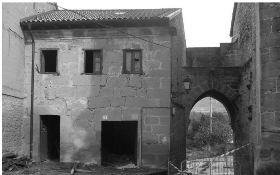
Figura 2. Fachada meridional del antiguo ayuntamiento y Puerta del Arco.
