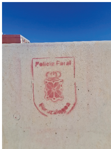
Figura 11. Sello de la policía foral de Navarra (Foruzaingoa), estampado en un New Jersey que sirve de barrera de protección en el Puente Nuevo de Paiporta.
