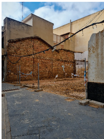
Figura 10. Desescombros de la casa de la Fineta
