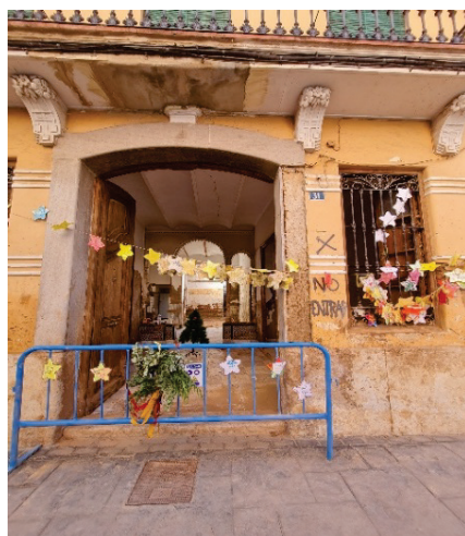
Figura 12. Colocación de estrellas decorativas de la Navidad en una de las viviendas afectadas.
