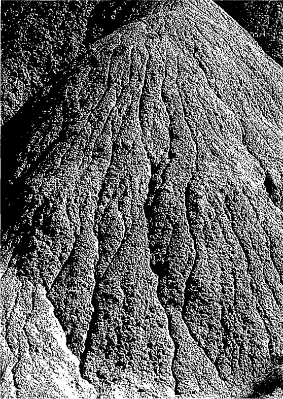
Figura 3. Vista de una ladera. Los regueros, el encostramiento superficial, el agrietamiento y la falta de vegetación son las características más destacables
