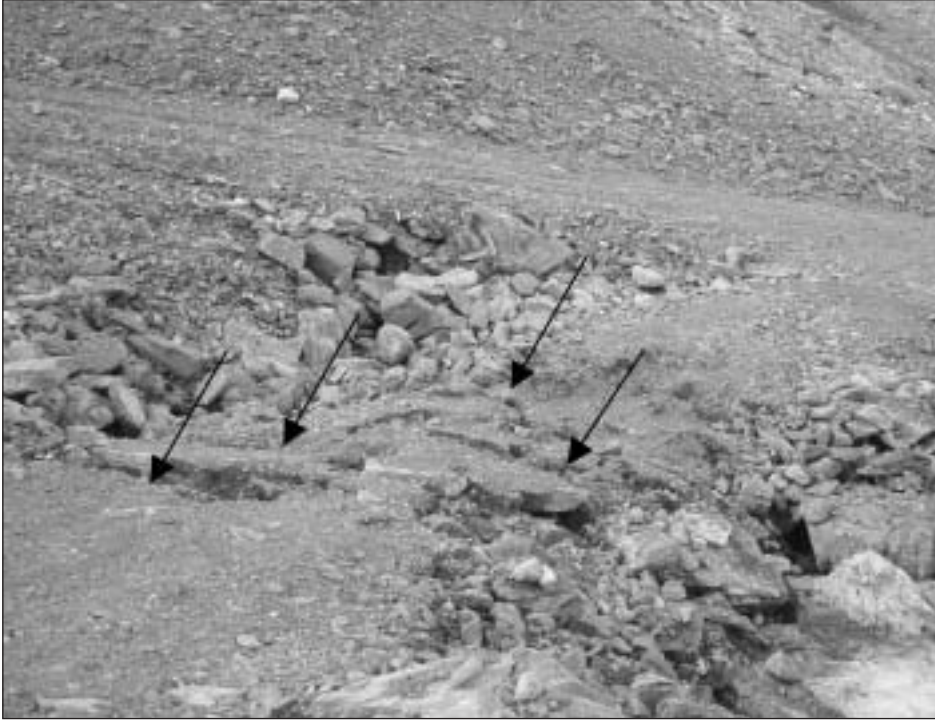
Foto 3. Detalle de las grietas en la pista de acceso (flechas negras) en el flanco Este del glaciar rocoso. Indican el reciente desplazamiento a favor de la pendiente del cuerpo central del glaciar.
