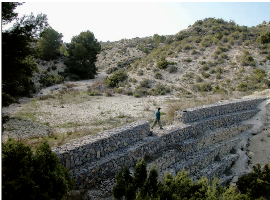
Figura 3. Dique construido en 1962, recocado en 1996 y colmatado en la actualidad
