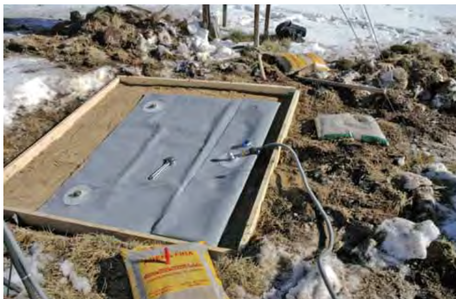
Foto 2. Detalle de la instalación del colchón de nieve.
