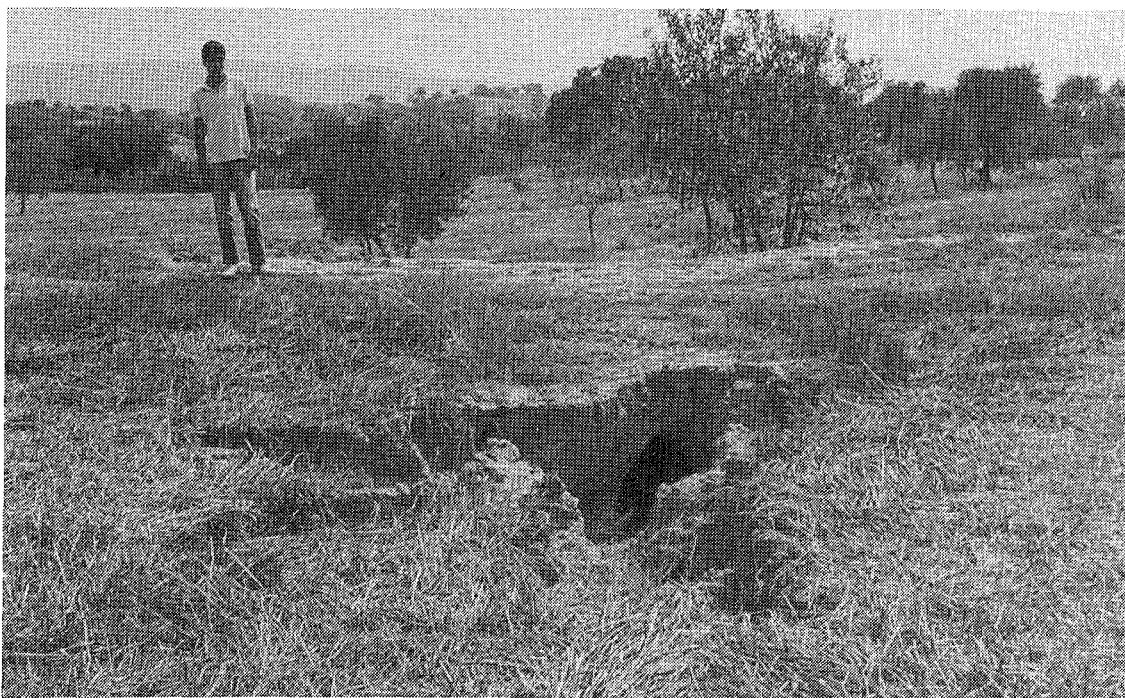
Foto 2. Pequeño hundimiento que permite observar un conducto horizontal subsuperficial junto al borde de su bancal y desarrollo inicial de una cárcava. Azlor (Huesca).
