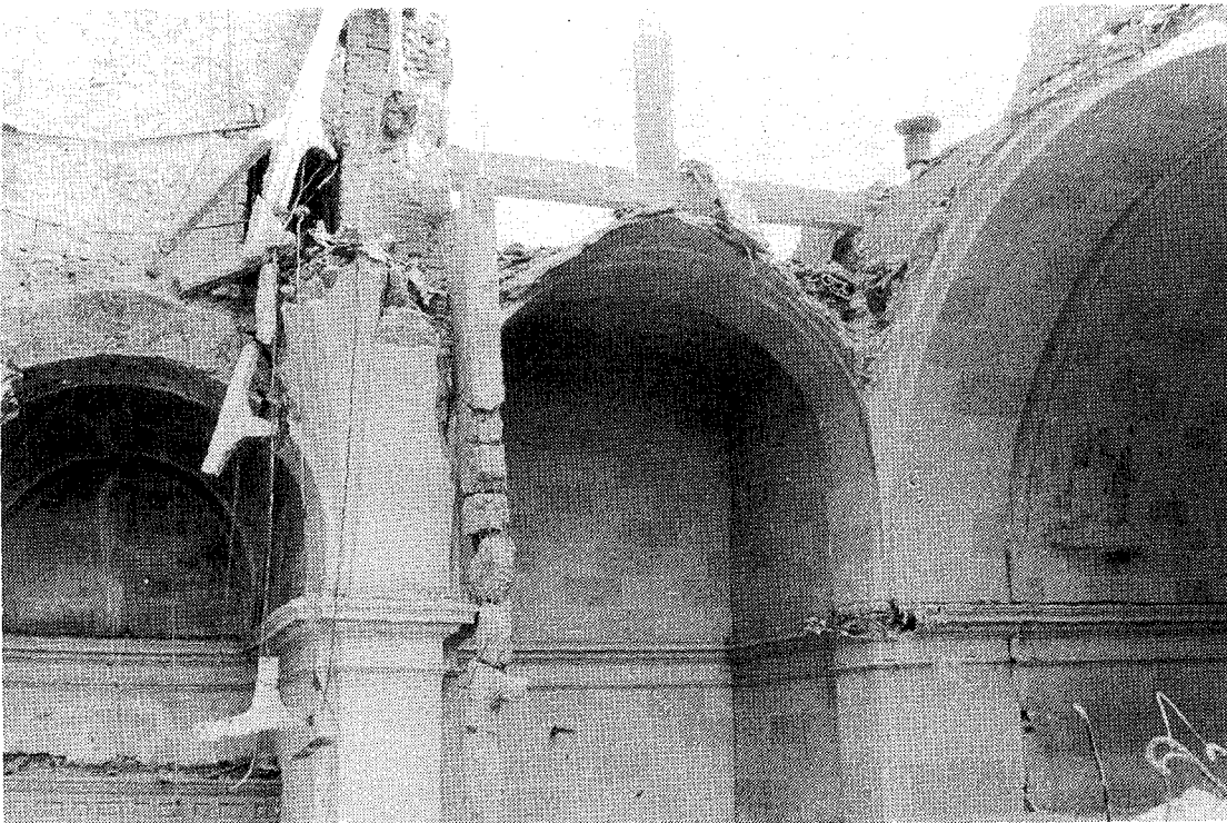
Lám. 6.- Restos de las capillas del lado de la epístola. Obsérvese el pilar hecho de ladrillo y los arranques de los arcos sobre las pilastras.
