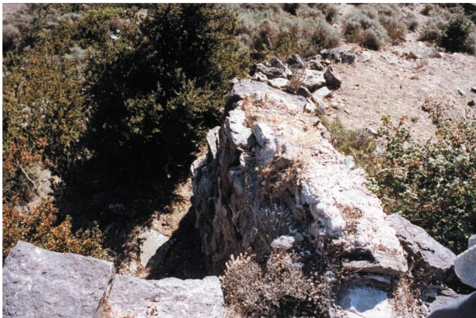
Figura 8. Detalle del ábside
