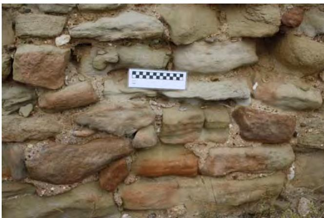
Lámina 72. Lavado y erosión de fábricas. Detalle.
